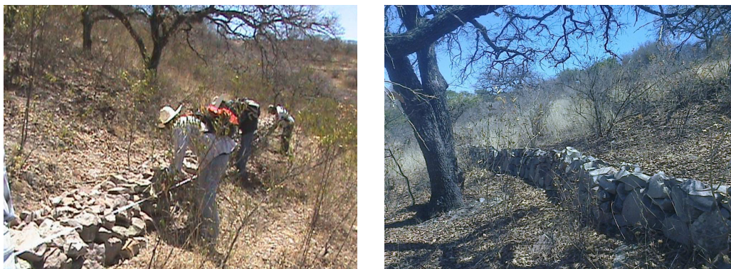
Imágenes 7.6 A y B. Construcción de Terrazas de piedra acomodada y Terraza Concluida.
