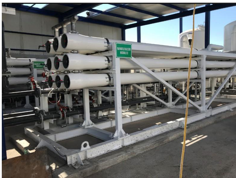
Imagen 4.4. Vista de ambos módulos de la planta de nanofiltración construida en San Pedro de las Colonias, Coahuila.
