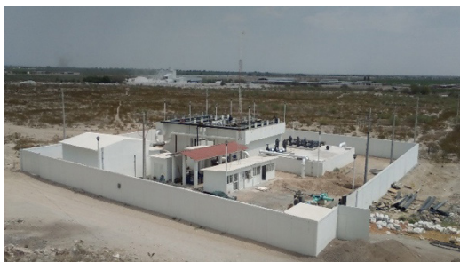
Imagen 5.2-C. Planta potabilizadora de filtración directa a gravedad de los pozos Transportes en Gómez Palacio, Durango.
