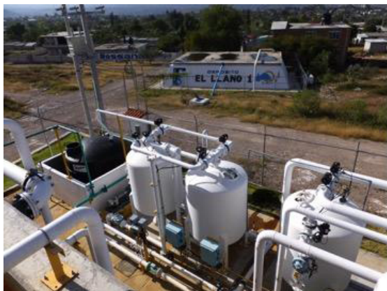
Imagen 5.5. Planta para la remoción simultánea de arsénico y fluoruro
