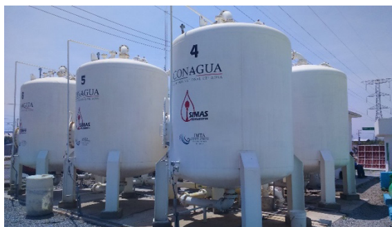
Imagen 5.2-B. Planta potabilizadora de filtración directa a presión del pozo 7 en Matamoros, Coahuila.
